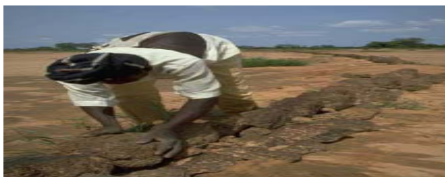
Photo.13 : Cordons de pierres (Burkina Faso) Photo.14 : Entretien de cordons de pierres(Burkina Faso)
