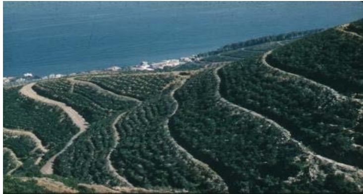
Photo.15 : Aménagement d'un versant en banquettes (Algérie).
